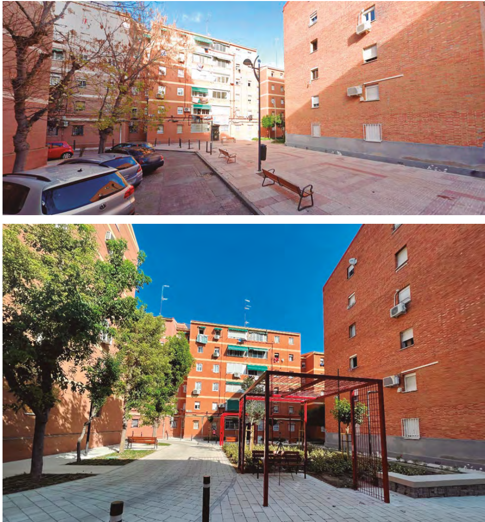
Figura 5: Estado inicial previo a la intervención y final tras la intervención en la plaza de Hortensia, en Las Margaritas
