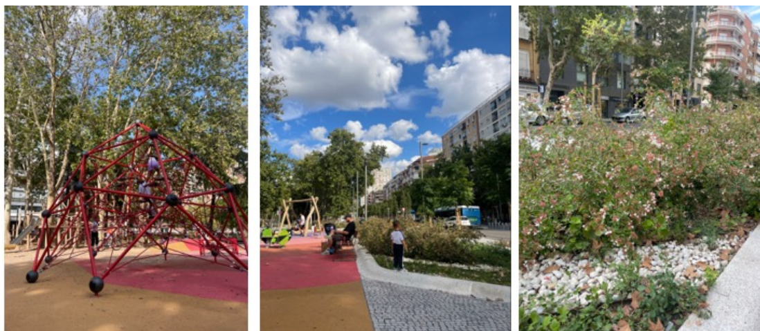
Figura 11: Intervención en calle General Perón de Madrid, con suelos de drenaje sostenible, vegetación autóctona con bajo mantenimiento y riego controlado, y nuevos espacios de juego para niños y adultos integrados.
