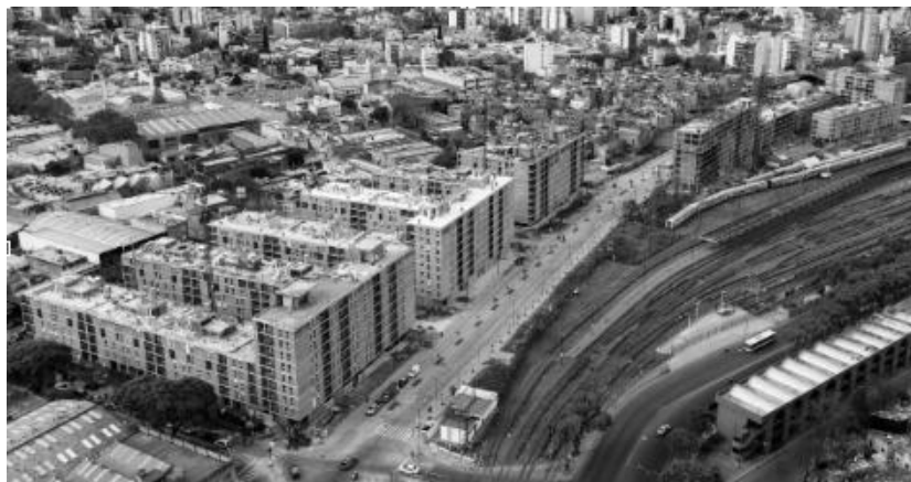
Figura 1. Vista del barrio histórico del Playón de Chacarita y los conjuntos habitacionales nuevos
