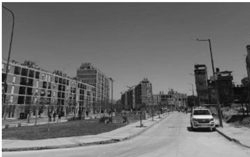
Figura 2. Nuevo espacio público entre la Avenida Triunvirato y el nuevo tramo de Fraga
