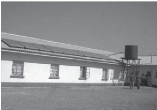
IMAGEN 1. SISTEMA DE TERMOSIFÓN DE PRODUCCIÓN LOCAL PARA UN INTERNADO, ZIMBABUE.
