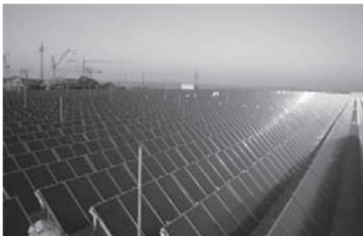
IMAGEN 2. VISTA DEL CAMPO DE COLECTORES SOLARES TÉRMICOS DE 36.305 M<sup>2</sup> INSTALADOS EN EL TEJADO DE UN ENORME ALMACÉN. FUENTE DE LA FOTO: MILLENNIUM ENERGY INDUSTRIES
