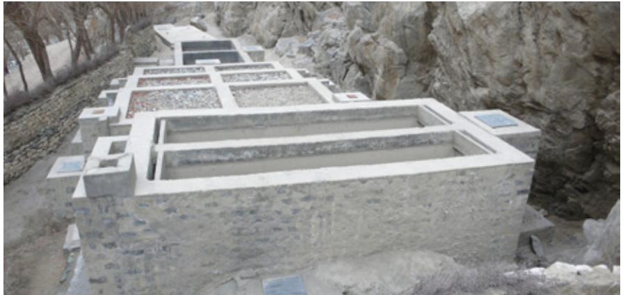
Para la depuración del barrio modelo a instalar en Talis, se propone un modelo simple de fosa séptica, de triple contenedor.
