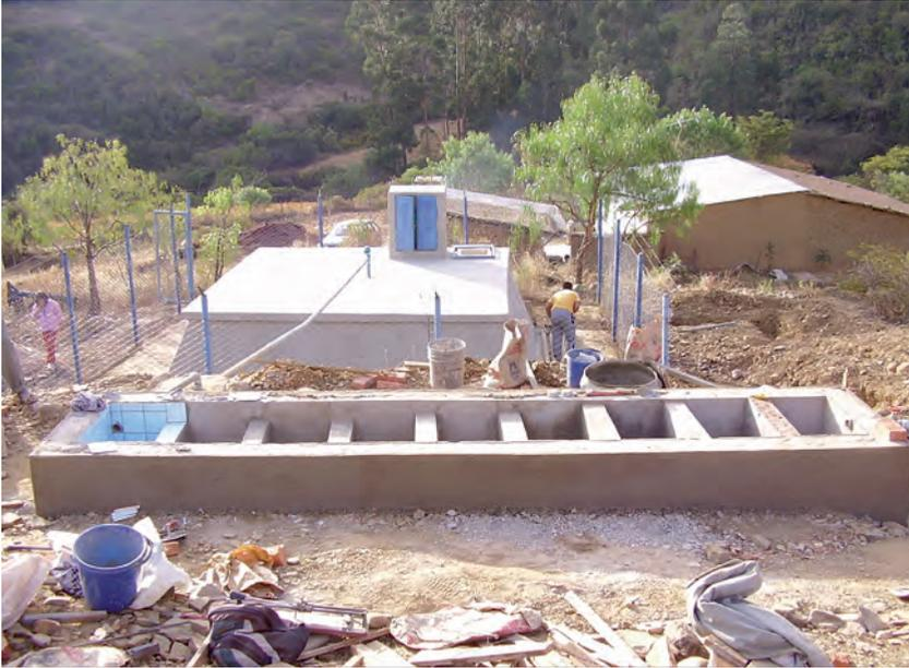
Obras de instalación de sistema de filtros a la entrada del tanque de almacenamiento
