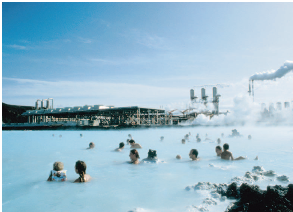
Central geotérmica, Islandia.
