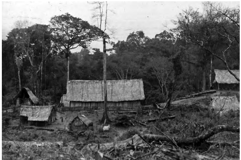
Proceso de construcción, Santa María Tzejá, años 70's.
