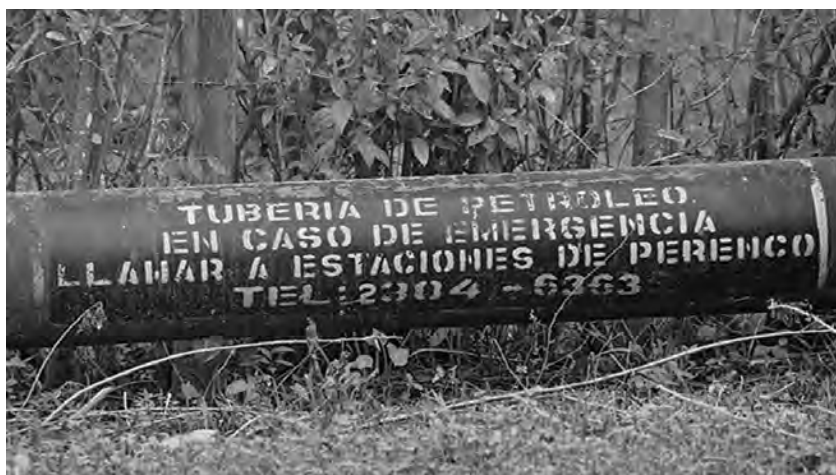
Tubería petrolera en la FTN.
