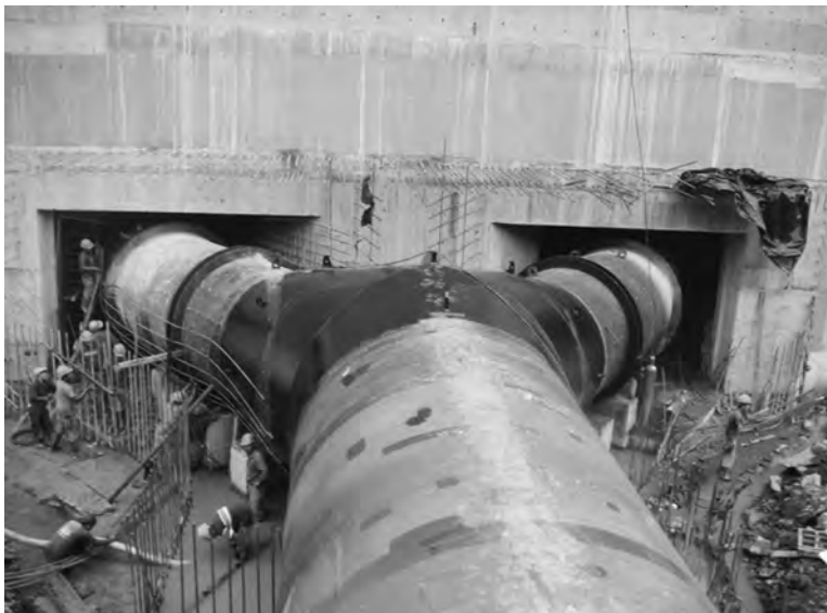
Tubería de la Hidroxacbal. Nebaj. IMA 2008.
