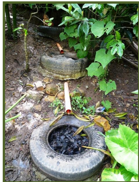
Ilustración 11 Filtro para aguas grises, La Pinada
