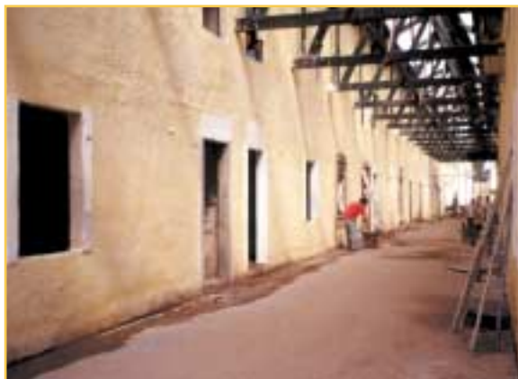
Viviendas sociales. Guatemala.
