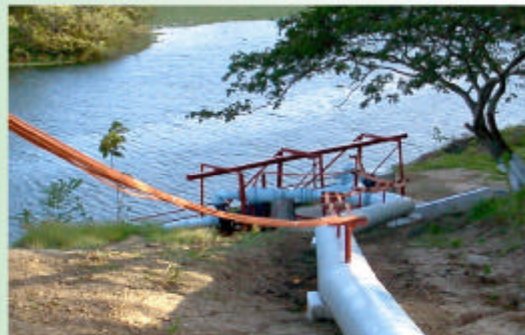
Abastecimiento de agua potable
