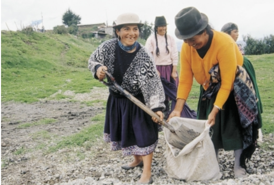
Un grupo de mujeres recoge grava para pavimentar un canal de riego en el valle del río Cañar, en Ecuador. La organización de grupos en el valle ha concedido a muchos agricultores los medios para regar sus cosechas con agua limpia.
